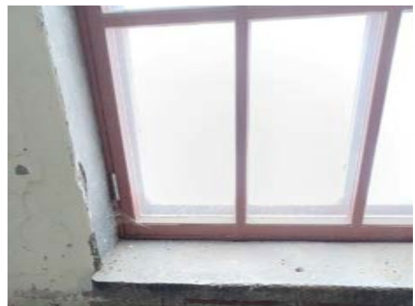
Kuva 99. Ikkunat ovat uusitut. Vain alimmaisissa puitteissa on 6-ruutuinen jako.
