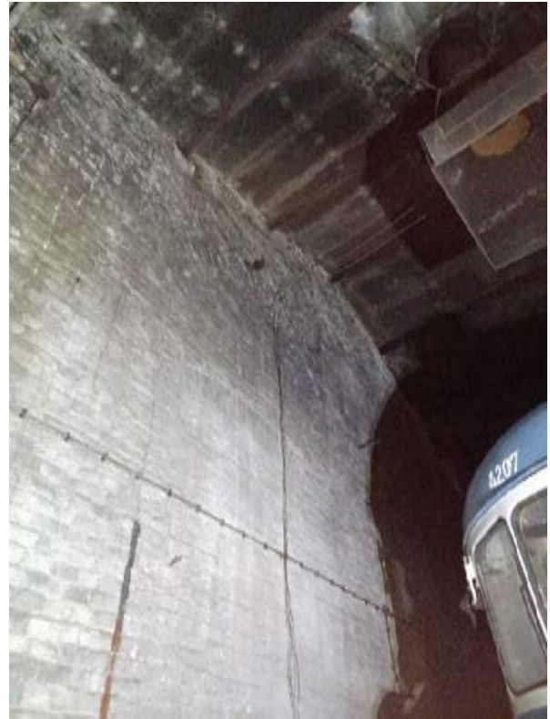
Kuva 89. Tila nro 8. Viereiseen pilttuuseen kuljetaan kapeasta oviaukosta (18). Seinässä näkyy umpeen muurattuja aukkoja useassa eri kohdassa.
