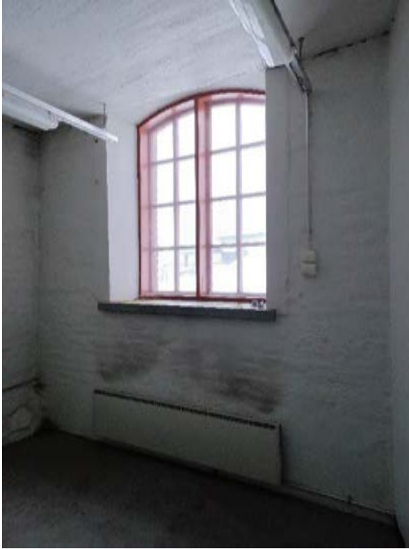
Kuva 65. Kaari-ikkunan puitteet on uusittu 1980-luvulla. Sisäpuitteet ovat yksiläiset. Ikkunan suunta lounaaseen, kohti Postin terminaalia.
