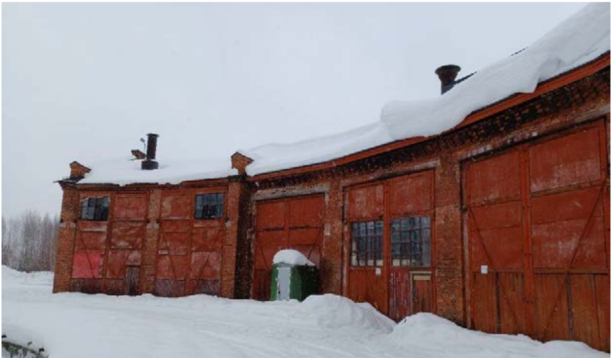
Kuva 34. Sisäpihaa kääntöpöydän vierestä kuvattuna. Rakennuksen pohjoispäädyn tilat 1–4.
