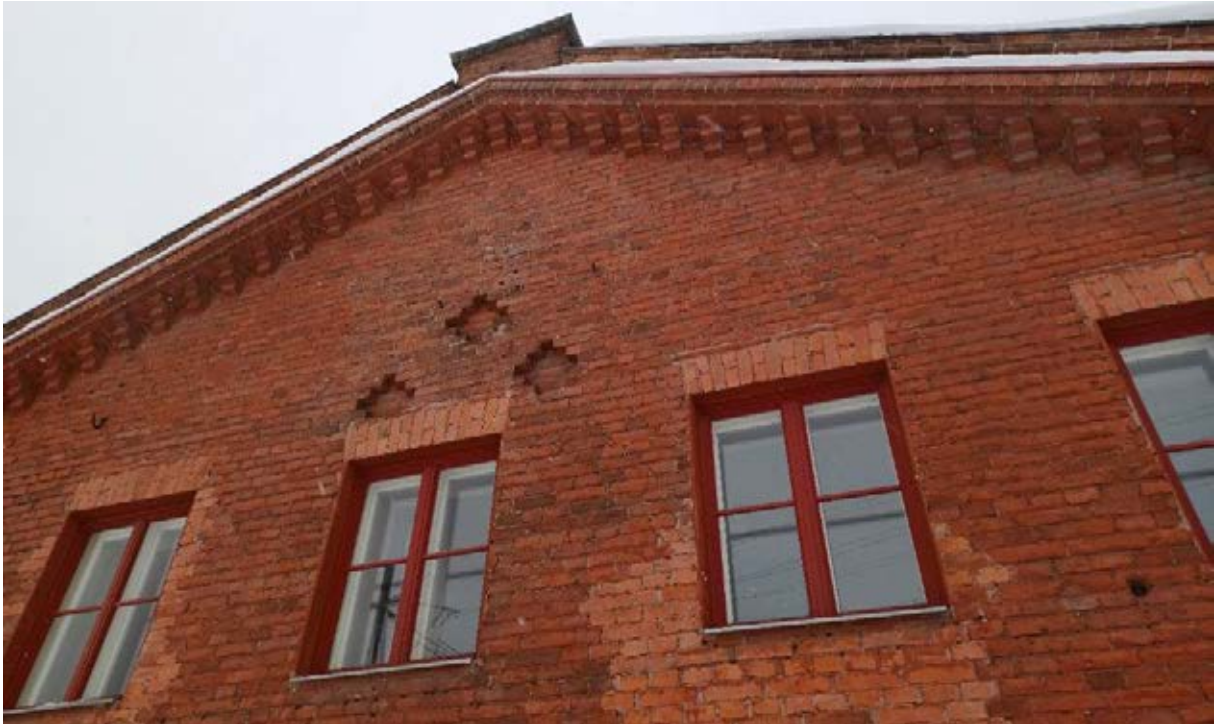
Kuva 56. Toimistopäädyn ikkunoita länteen päin.
