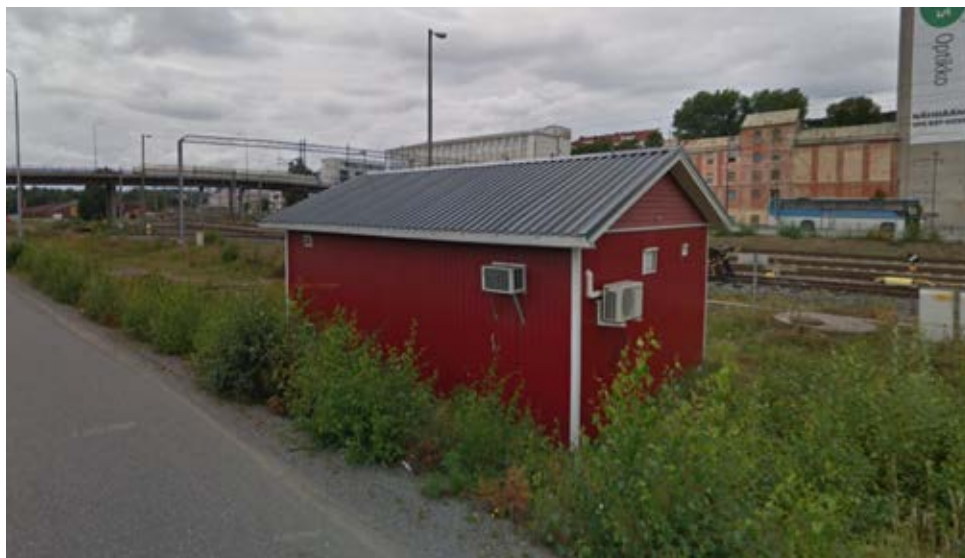
Kuva 18. Rautatiehen liittyvä sähkömuuntamo (Google 2011)
