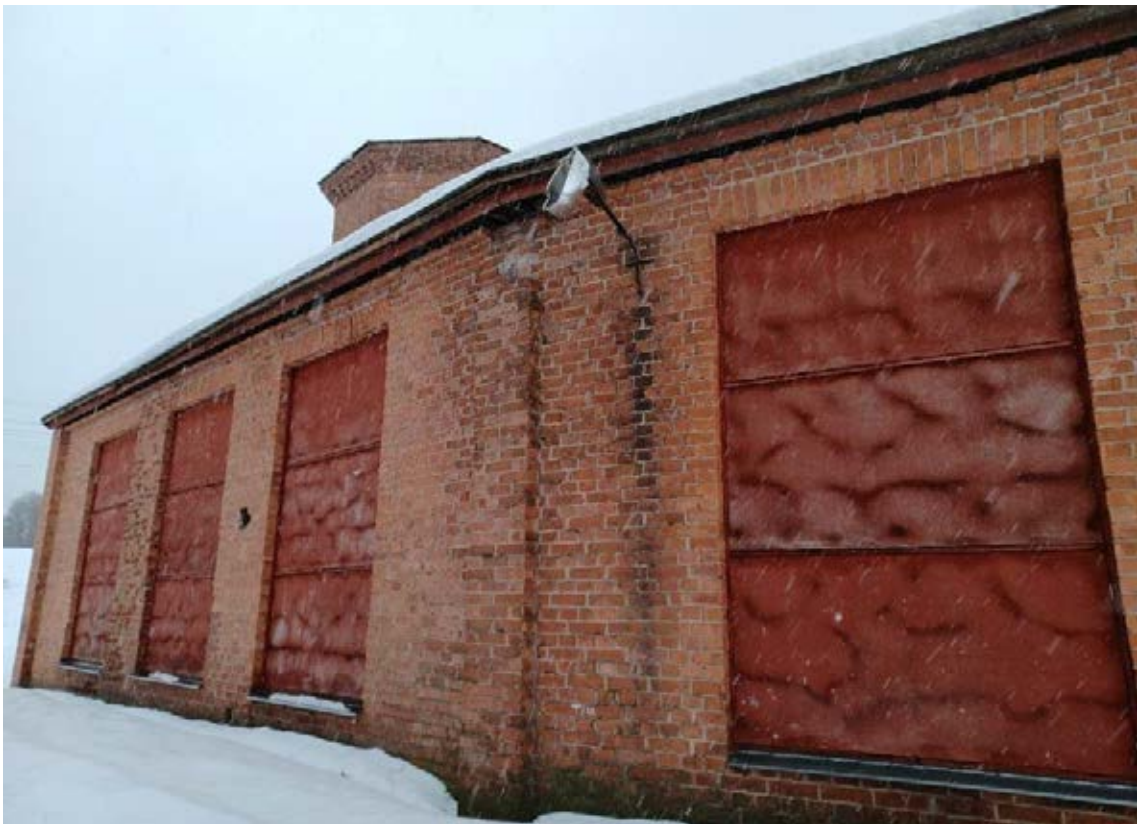
Kuva 43. Laajennusosan ikkunat on peitetty ilkkivallan vuoksi.
