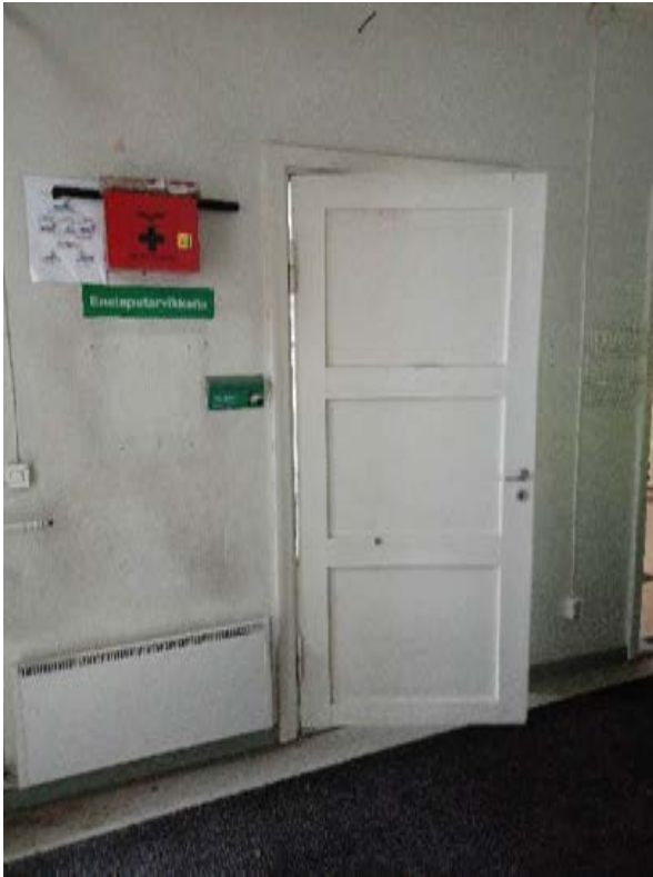
Kuva 67. Ala-aulan seinät on päällystetty Enso-pahvilla. Väliovet ovat alkuperäisiä.
