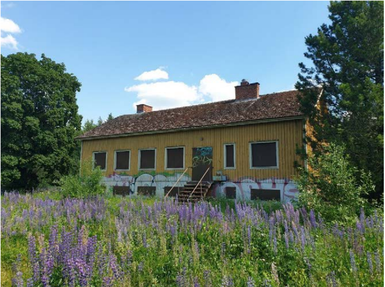
Kuva 3. Purkukuntoinen rakennus veturitallien pohjoispuolella.
