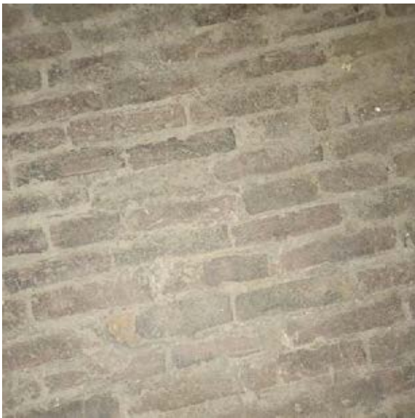
Kuva 75. Lattia on ladottu punatiilistä.
