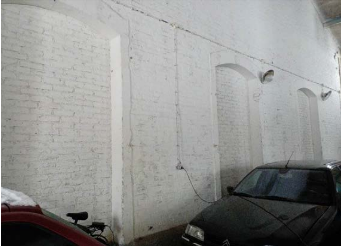
Kuva 106. Umpeen muurattuja oviaukkoja. Seinän takana on tila 3-4 eli petankkihalli. Seinällä näkyvät pyöreät valaisimet ovat alkuperäiset ja toimivat edelleen.
