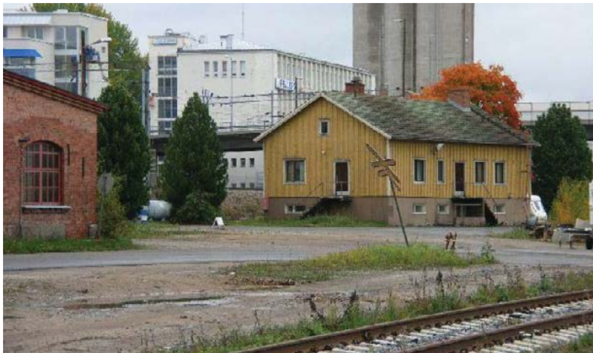
Kuva 17. VR:n vuonna 1951 rakennettu huoltorakennus (Petri Enqvist, 2006)
