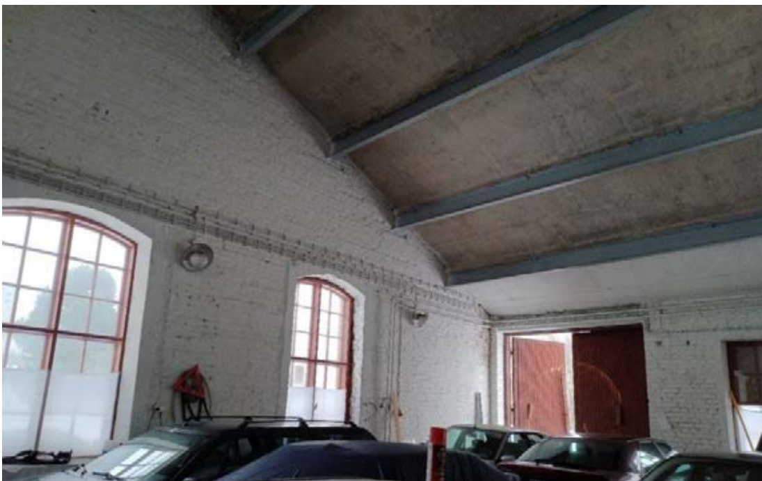
Kuva 107. Näkymä rakennuksen pohjoispäädystä kohti ovea 11.
