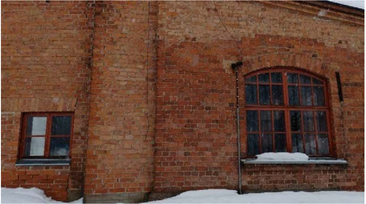
Kuva 60. Entisen polttoainevaraston ja pannuhuoneen ikkunat.
