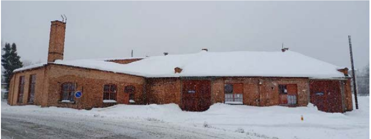
Kuva 33. Rakennuksen idänpuoleinen julkisivu.
