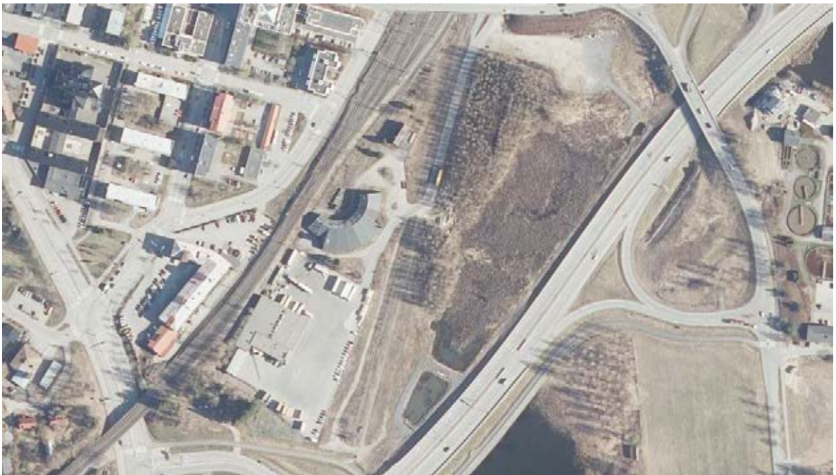
Kuva 21. Veturitalli ympäristöineen ilmakuvassa. Lähde: Maanmittauslaitos. Paikkatietoikkuna.
