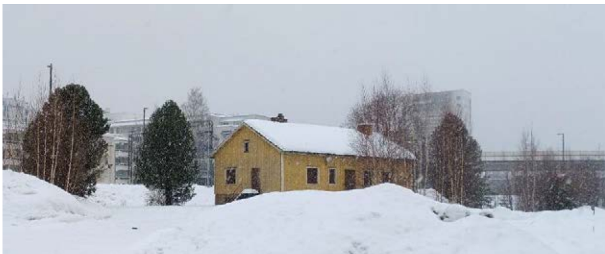
Kuva 23. Entinen huoltorakennus veturitallien pohjoispuolella.
