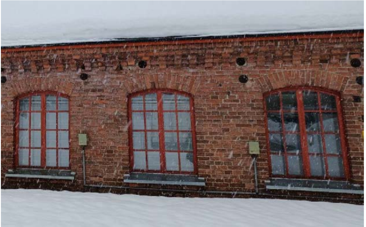
Kuva 58. Toimistopäädyn ikkunat etelän suuntaan.
