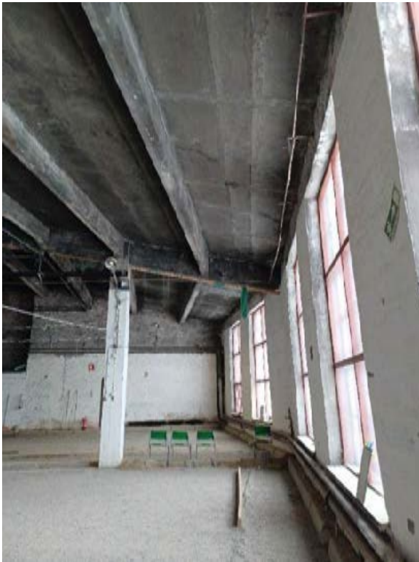
Kuva 101. Vasemmanpuoleisessa kuvassa näkyy laajennusosan betonipalkkeja ja oikealla näitä vanhempaa perua olevia I-palkkeja sisäkaaren puolella.
