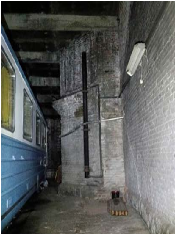
Kuva 90. Tilan 8 seinäpintaa, edessä vesitorni.
