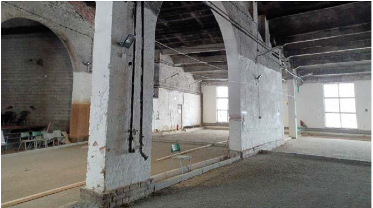
Kuva 97. Pilttuiden lattiapinnat on päällystetty hiekalla.
