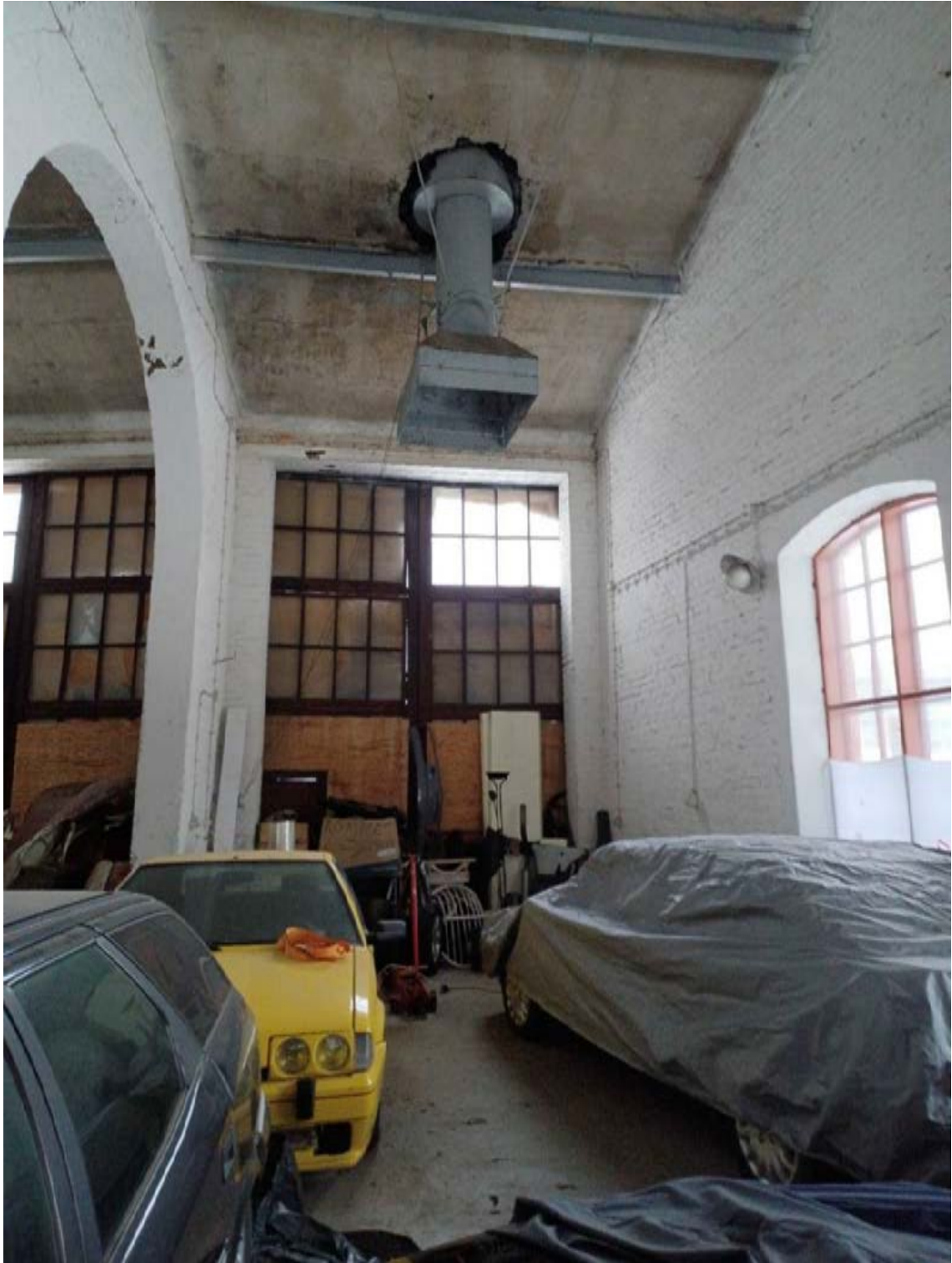
Kuva 105. Tilassa on betonilattia ja tiiliseinät. Puisten, alkuperäisen mallin mukaisten tallinovien (1 ja 2) suuret, moniruutuiset ikkunat on peitetty vanerilla ilkeivallan vuoksi. Ikkunoiden sisäpuutteet vaihdettu 1-ruutuisiksi. Pyöreät valaisimet todennäköisesti alkuperäiset, ja toimivat edelleen.
