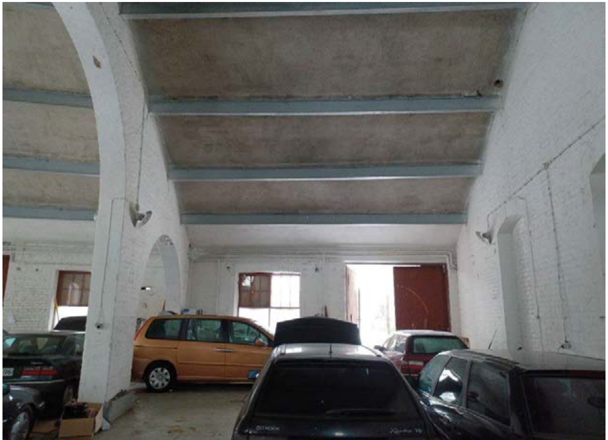
Kuva 104. Tila kuvattuna kohti toista sisäänkäyntiä (ovi 12).
